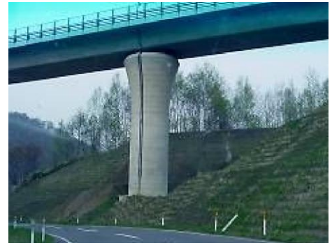
写真-1.6 張出式橋脚(円形断面)
