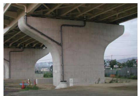
写真-1.5 張出式橋脚(矩形断面)
