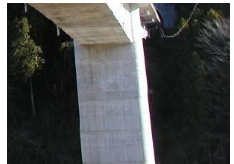
写真-1.3 壁式橋脚(矩形断面)
