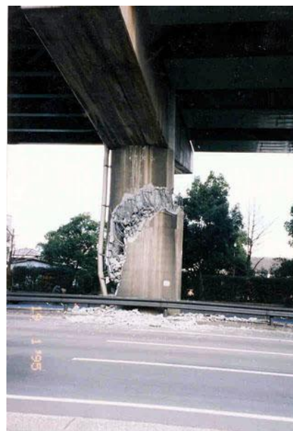
写真-2.4 せん断破壊
