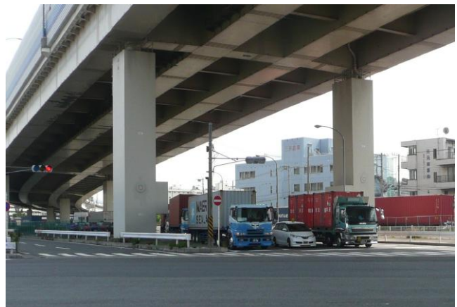
写真-1.2 鋼製橋脚（単柱式）
