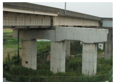
写真-1.8 ラーメン式橋脚
