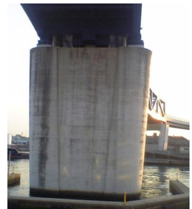
写真-1.4 壁式橋脚(小判型断面)
