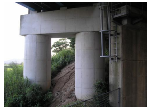
写真-1.7 パイルベント式橋脚
