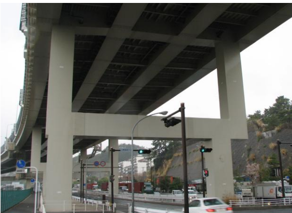
写真-1.1 鋼製橋脚（ラーメン式）
